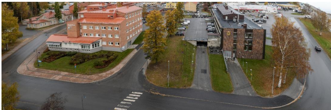
Foto på angränsande stadshuset och polishuset, nordlig vy från planområdet. Stadshuset till vänster, och polishuset till höger i bild.
