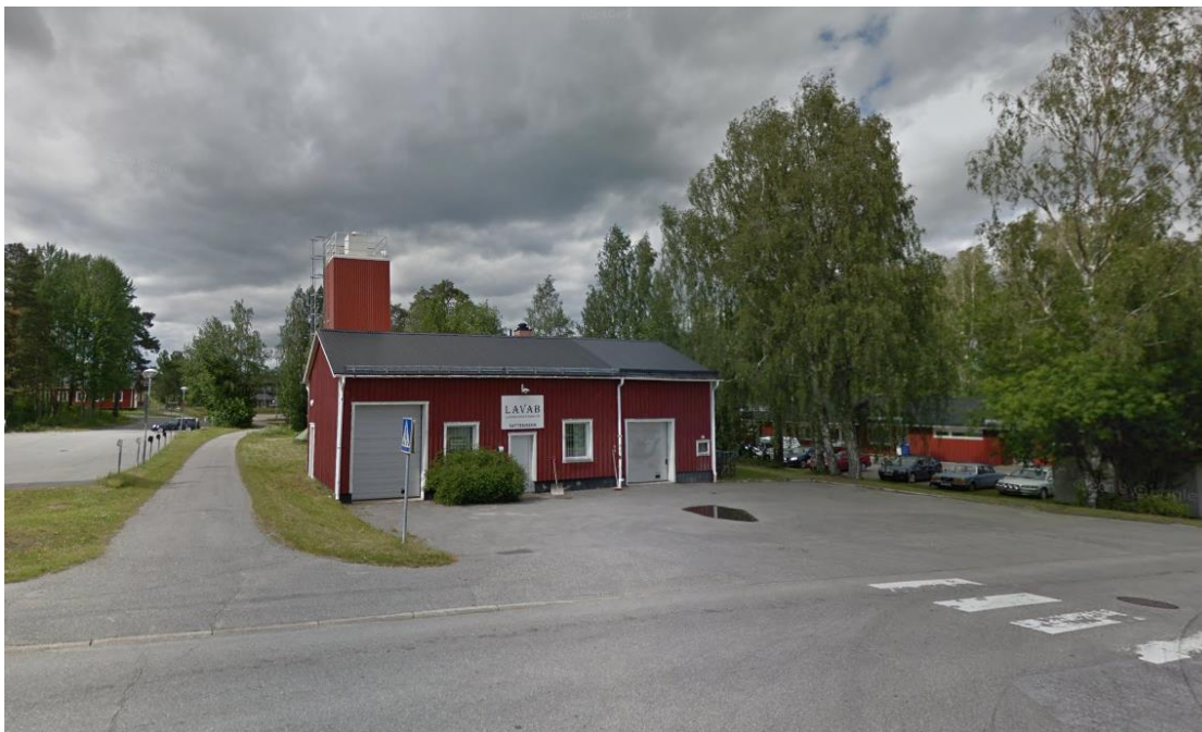
Figur 8. Bebyggelsen inom planområdet: Lycksele vattenverk. Bildkälla: Google Maps, hämtad 2024-10-09.
